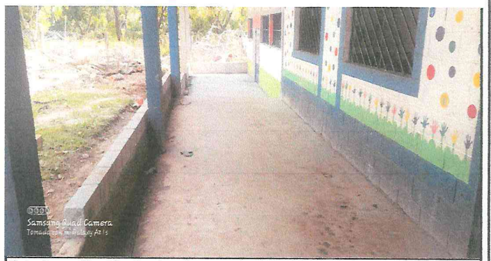
Foto 6: sustitución de piso de cemento.
